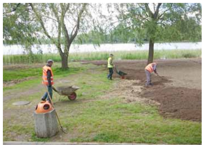
- odbudowa zieleńca ciąg dalszy - ul. Zielona.
