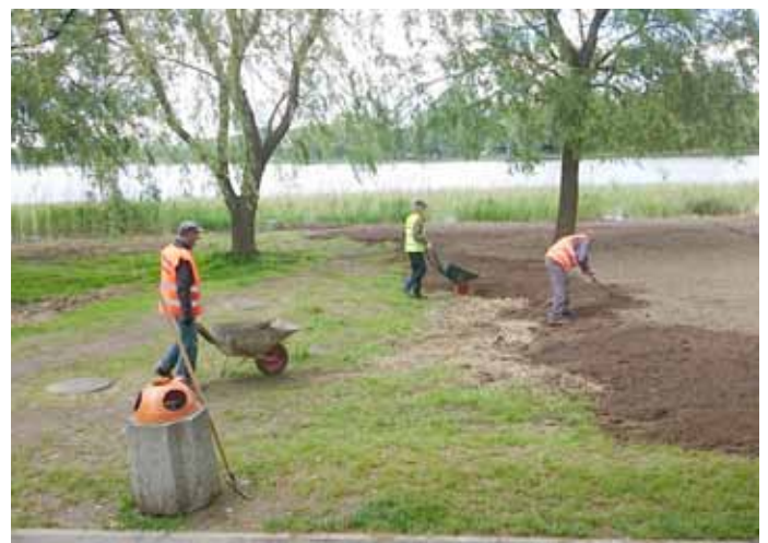
- odbudowa zieleńca ciąg dalszy - ul. Zielona.
