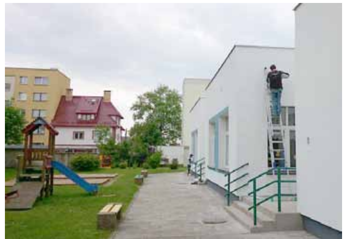
- prace wykończeniowe przy remoncie elewacji Przedszkola nr 3;
