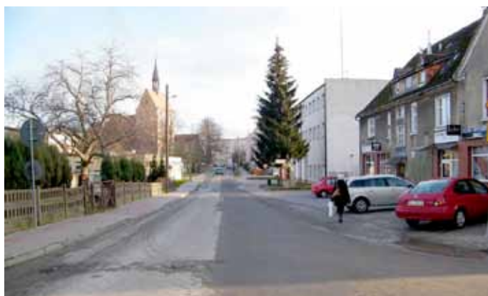
Tak wyglądało przed remontem...
