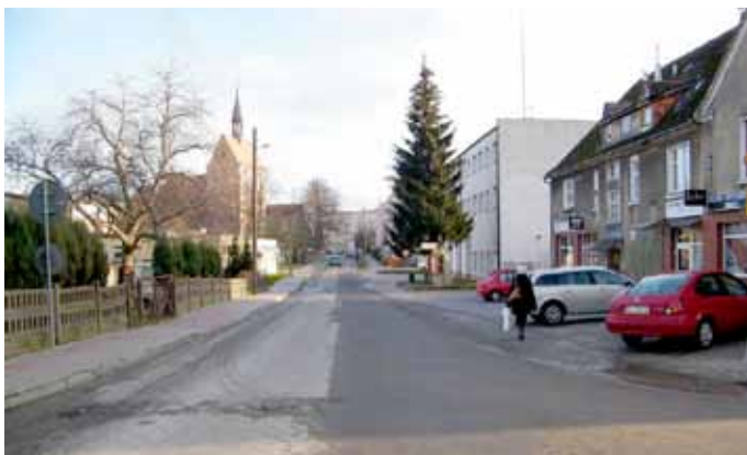
Tak wyglądało przed remontem...
