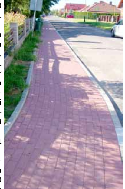
Tak wygląda po remoncie
