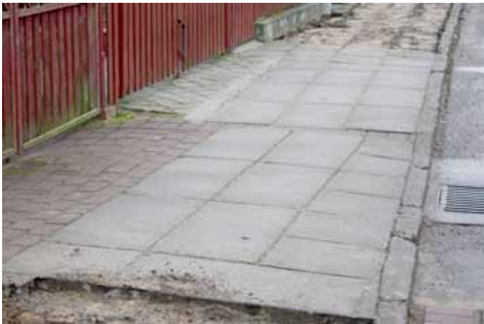
Tak wyglądało przed remontem
