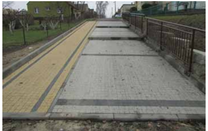
Schody ul. Kilinskiego po remoncie
